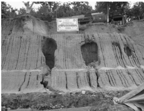
Gambar 5. Tampak depan lereng tergal beserta kondisi keruntuhan pada badan lereng (Dokumentasi, 2016)
