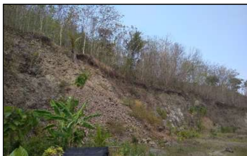
Gambar 5. Kenampakan lereng yang terbentuk karena aktifitas penggalian dan terjadi gerakan massa
