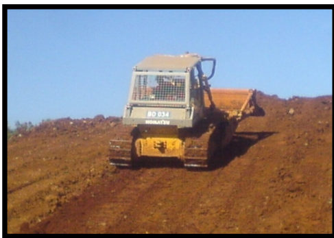
Gambar 3 Foto Pemadatan Bijih Nikel Kadar Rendah pada stock yard
