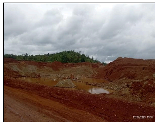
Gambar 2 Lokasi Rencana Disposal
