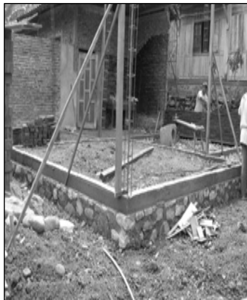
Gambar 12. Lokasi di RT 8 RW 3 yang relatif stabil dan membuat warga tidak ragu membangun rumah.
