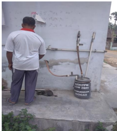
Gambar 7. Pemurnian biogas
