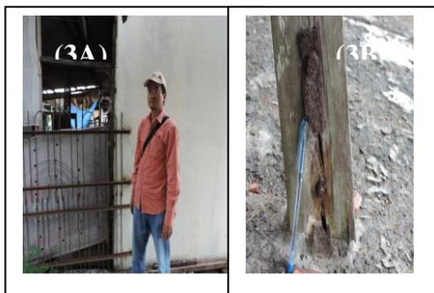
**Gambar 3.** Kenampakan pagar berkarat di rumah penduduk pada jarak kurang lebih 200 meter utara lokasi letupan gas gunung lumpur Bledug Kuwu ( $07^{\circ}06'56,55''$  LS  $111^{\circ}07'17,43''$  BT) (gambar 3A) dan kenampakan *close up* korosi pada logam di sekitar lokasi tersebut (gambar 3B)
