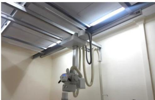
Gambar 1. *Ceiling Suspension* pada alat Rontgen.
