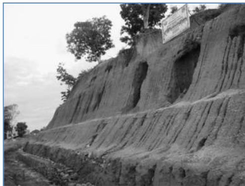
Foto Lampiran 2. Lereng yang tergal sebelum perkuatan Titik BH1 (Dokumentasi, 2016)
