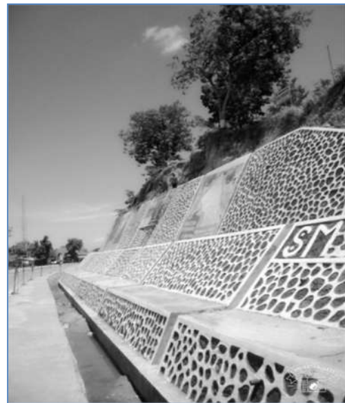
Foto Lampiran 3. Lereng yang tergal setelah perkuatan berupa pasangan batu gunung Titik BH1 (Dokumentasi, 2017)
