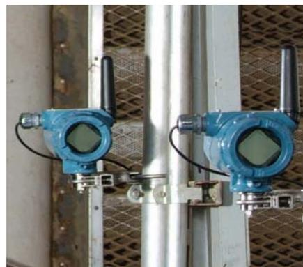
**Gambar 3** Pemasangan Transmitter monitoring Vibrasi pada badan pompa
