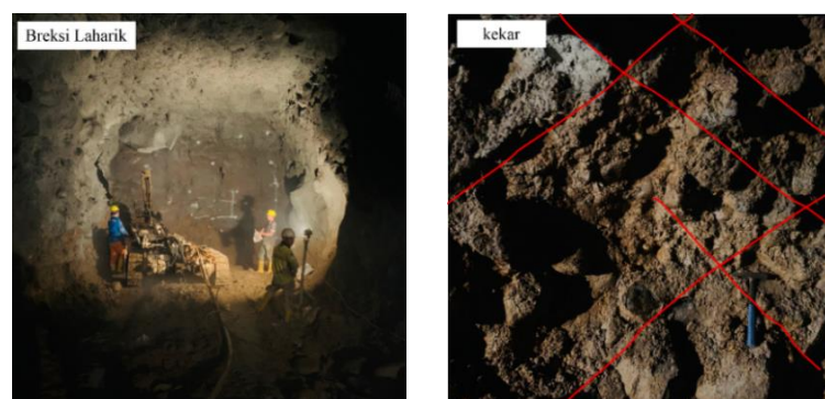
Gambar 5. Kenampakan STA 285,309 – 288,104 dengan Face tunnel yang tersusun litologi breksi laharik (kiri) dan pada wall segmen terdapat bidang diskontinuitas (kanan)
