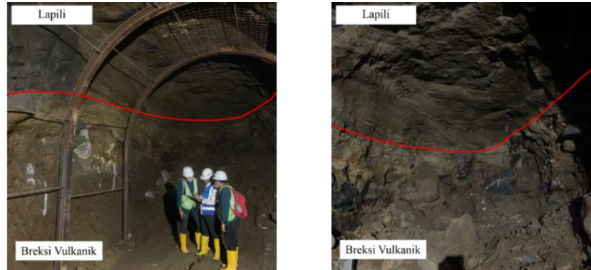
Gambar 10. Kenampakan STA 0+420,144 – 417,134 dengan face tunnel yang tersusun litologi lapilli kontak dengan breksi vulkanik (kiri) dan Wall segmen terdapat kontak litologi lapilli dengan breksi vulkanik (kanan)
