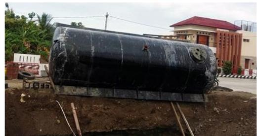
Gambar 3. Desain dan Bentuk Fisik *Underground Tank* SPBU Pertamina (Tambun, 2015)
