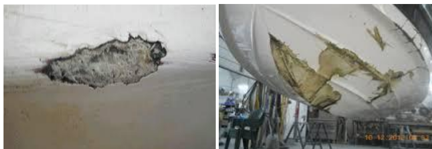
Gambar 11 Visual kerusakan/keretakan pelat zona lambung
