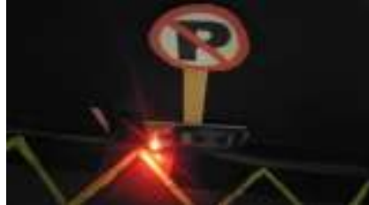
Gambar 3. Pemasangan RFID Reader pada Rambu
