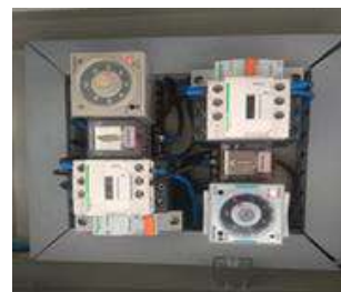
Gambar 4. Rangkaian Blok Diagram ATS dan pelaksanaannya
