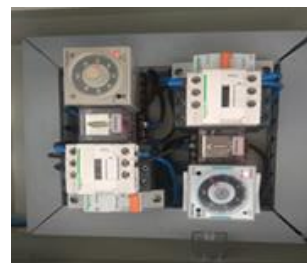
Gambar 4. Rangkaian Blok Diagram ATS dan pelaksanaannya
