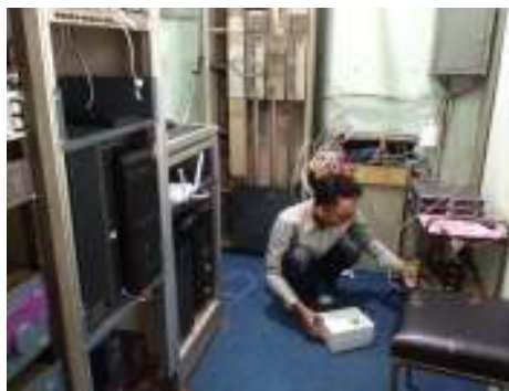
Gambar 11. Potret Pemasangan Alat di Ruang Server LPP RRI
