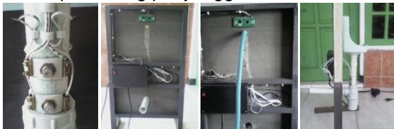
Gambar 12 Pemasangan perangkat elektronis sistem pada penyangga
