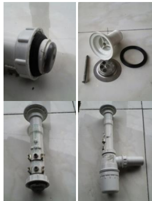
Gambar 11 Pemasangan pipa pembuangan dengan tabung sensor
