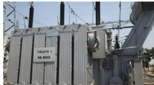
Gambar 3.2 Bentuk Fisik Trafo I 60 MVA XIAN SFZ-60000/150
