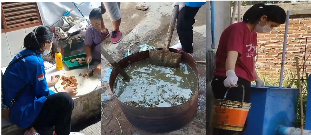
Gambar 6. Pelatihan Operasional Biodigester (Penginputan limbah ternak dan tempe, serta EM-4 ke Bak Kontrol)
