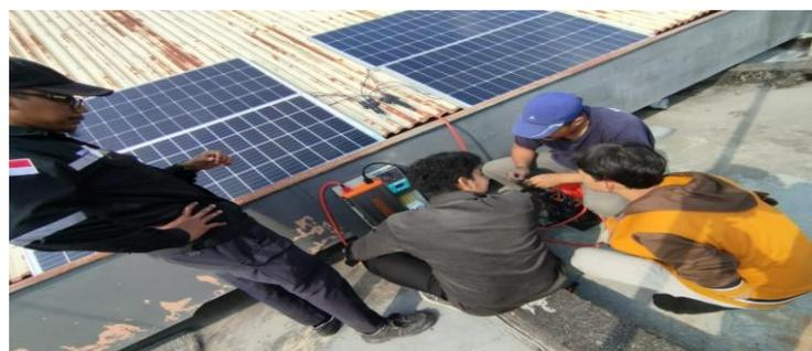
Gambar 3. Penyambungan 4 Buah Panel Surya
