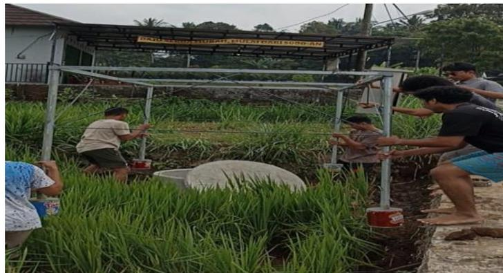
Gambar 2. Pemasangan Tiang Penyangga Panel Surya
