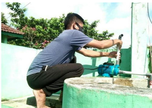
Gambar 2. Penyambungan Pipa Paralon
