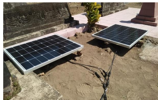
Gambar 3. Penyambungan 2 Buah Panel Surya
