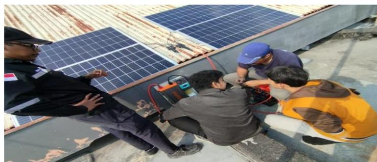
Gambar 3. Penyambungan 4 Buah Panel Surya
