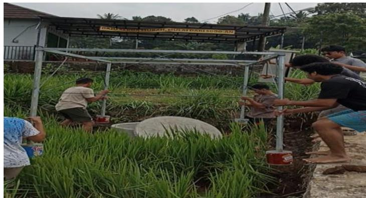
Gambar 2. Pemasangan Tiang Penyangga Panel Surya
