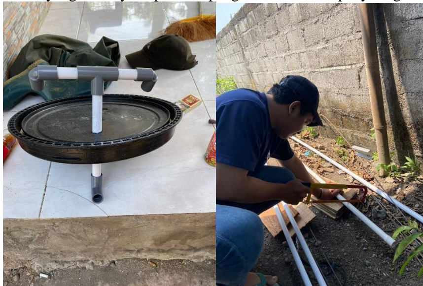
Gambar 4. Pembuatan instalasi saluran air
