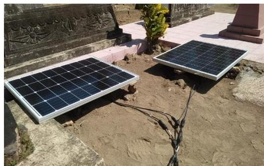
Gambar 3. Penyambungan 2 Buah Panel Surya
