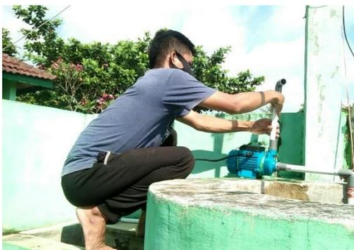
Gambar 2. Penyambungan Pipa Paralon
