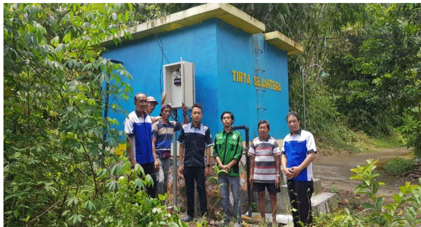
Gambar 8. Hasil instalasi pembangkit listrik tenaga mikrohidro (PLTMH)
