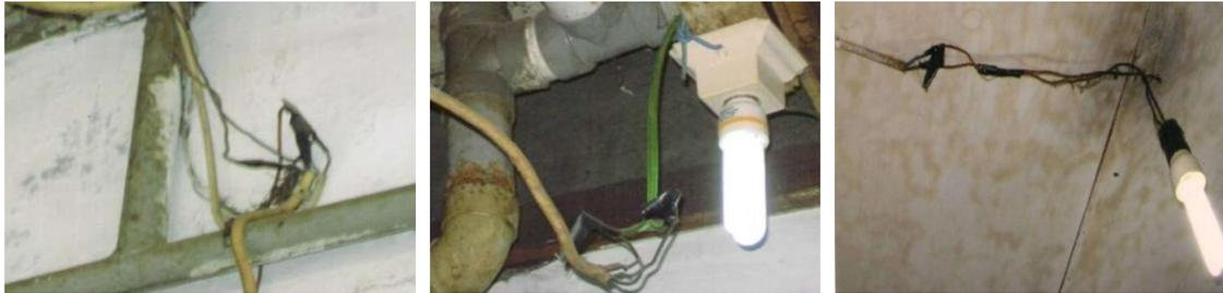
Gambar 5. Peralatan listrik yang tidak layak pakai (kabel terkelupas)
