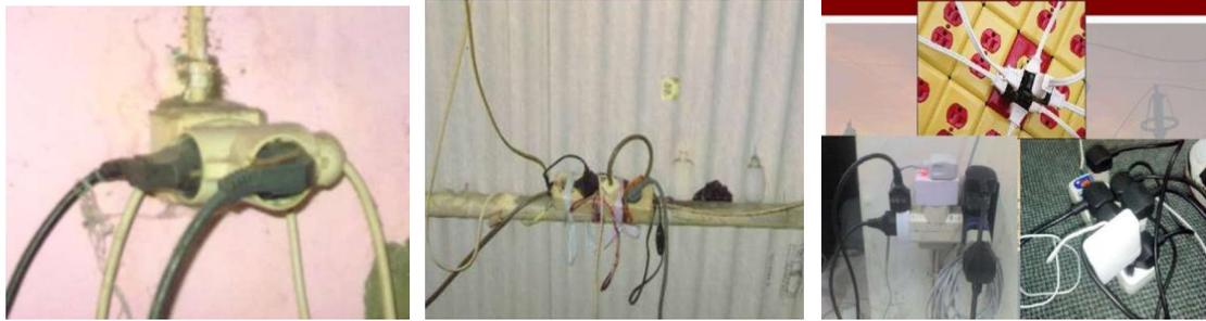
Gambar 4. Pemakaian terminal kontak yang bertumpuk-tumpuk
