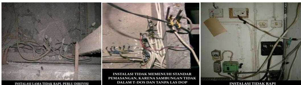
Gambar 6. Instalasi listrik yang tidak baik
